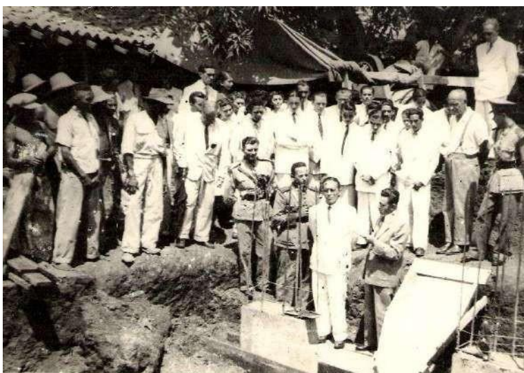
Figura 4 - Inauguração da Pedra Fundamental do 1º edifício de Teresina (1947)
